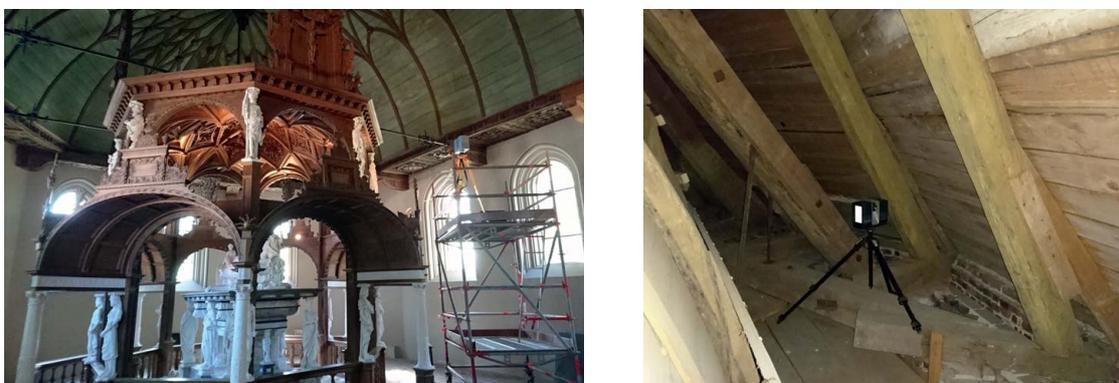
Abb. 3.1.11-2: Aufmaß des gesamten Bauwerkes mit 3D-Laserscanning
